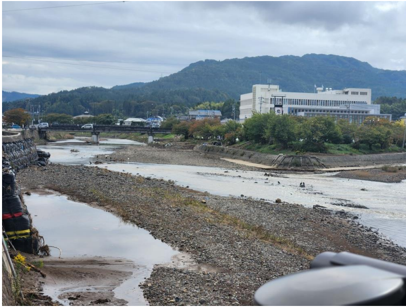
氾濫した河原田川と鳳至川 合流点遠景
